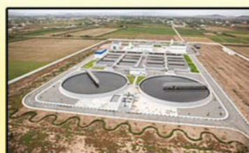
Station d'épuration des Eaux Usées - Grand Nador
