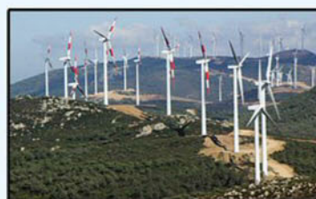
Parc Eolien de Tanger
